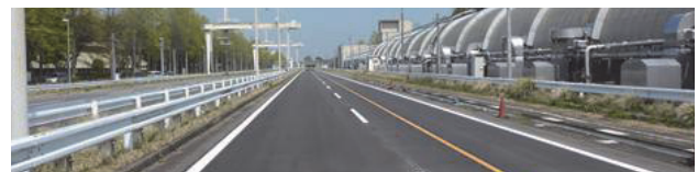
写真-1 試験施工路面
