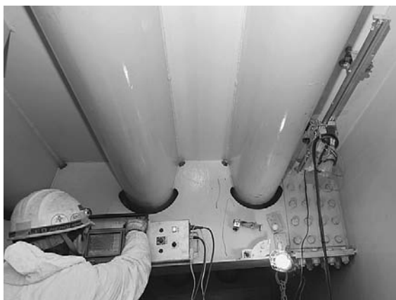
図2 超音波探傷法による鋼床版の疲労き裂の現地調査
