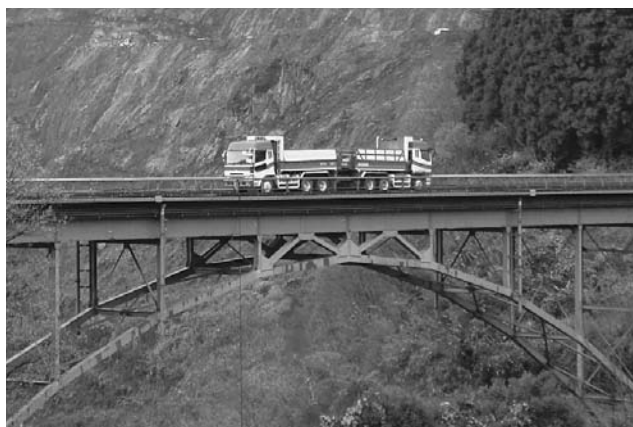
図3 アーチ橋の全体挙動を把握するための載荷試験
