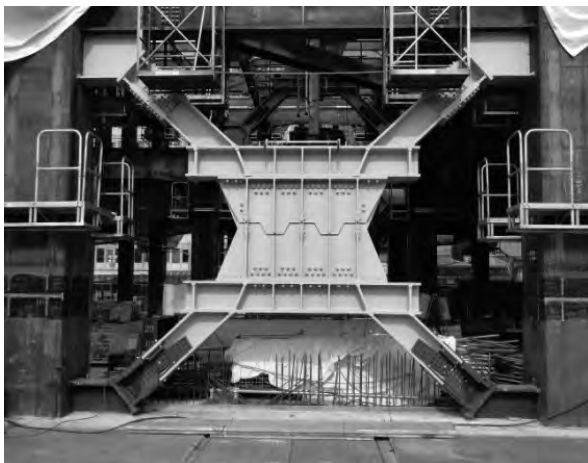
図1. Fe-Mn-Si 系合金制振ダンパー [1] (写真：竹中工務店)
