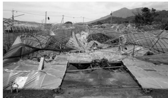
竜巻で被災したパイプハウス。台風による被害の様子と似ている。しかし、被災メカニズムは異なる<sup>(3)</sup>。
