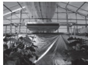
図5 地下水熱源熱交換器 図6 水熱源ヒートポンプ室内機
