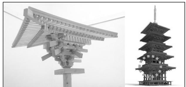
図2 制作した五重塔の屋根隅部
